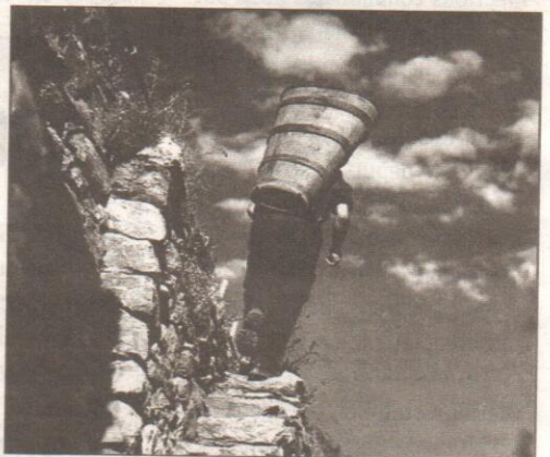
Escalier en pierres sèches, 1940-1950.
